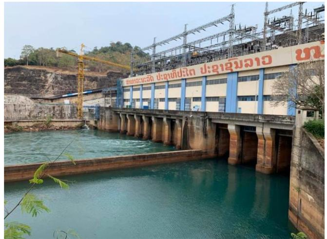
発電施設の増設工事中のダムとして特徴的なのは、稼働中の増設という工事的な制約（振動規制、発破禁止など）が多い中で、水があるダム堤体への穴あけ工事という極めて稀な工法でもあり、日本企業はその先頭に立って取り組んでいる。
